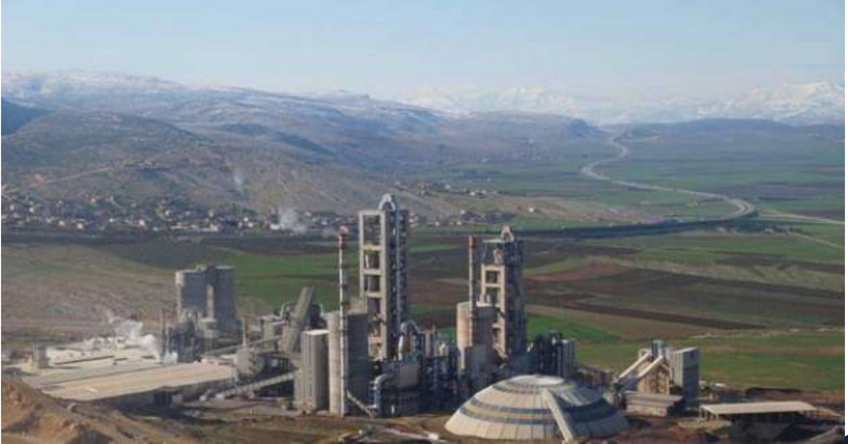
KÇS ÇİMENTO KÇS Çimento Fabrikası Projesi
