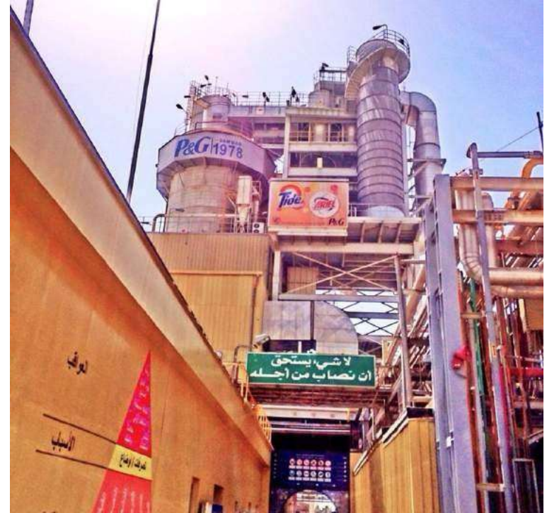
P & G / ARABİSTAN P&G Arabistan Dammam Deterjan Fabrikası Projesi
